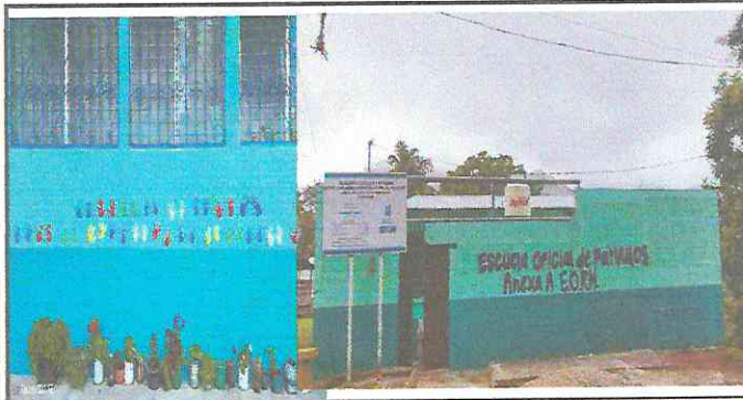
FOTO 6: MÓDULO 4 APLICACIÓN DE PINTURA EN TODA LA ESCUELA
