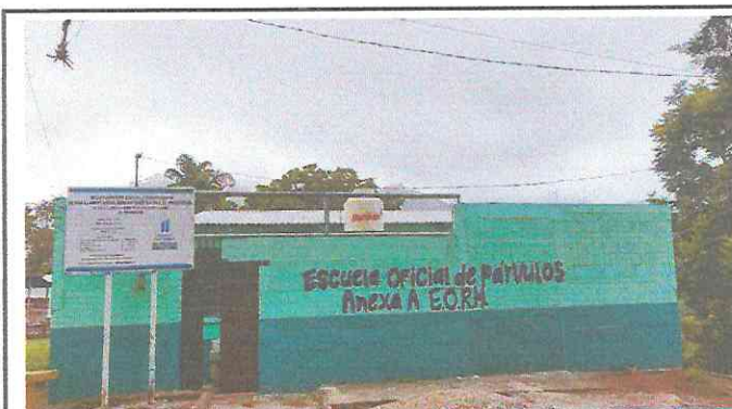
FOTO 4: MÓDULO 2 CONTINUACIÓN MURO PERIMETRAL, FABRICACIÓN DE PANTALLA SOBRE TERRAZA, SUSTITUCIÓN DE DEPOSITO DE AGUA
