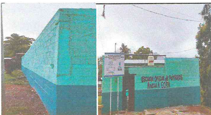
Foto 3: MÓDULO 2 FABRICACIÓN DE NUEVA PUERTA, CONTINUACIÓN DE MURO PERIMETRAL
