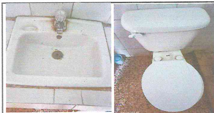
Foto 5: MÓDULO 3 CAMBIO DE KIKTS DE BAÑOS Y LAMANOS
