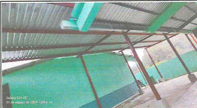
Foto 2: MÓDULO 1 TECHADO DE PATIO
