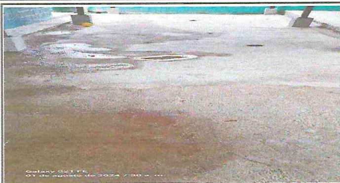
Foto1: MÓDULO 1 FUNDICIÓN NUEVA LOSA
